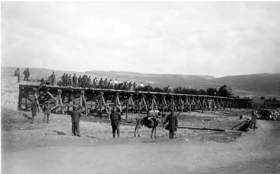
Ξύλινη γέφυρα κατασκευασμένη ἀπό τό Μηχανικό.
